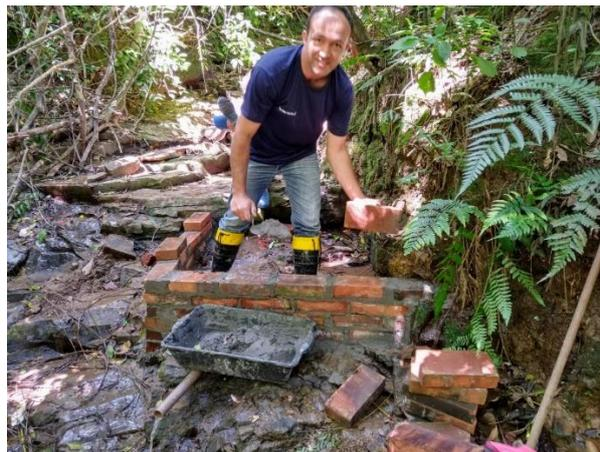
Na construção da estrutura de captação, faz-se necessário uma limpeza criteriosa nos arredores do local da intervenção e da nascente. Esta limpeza deve ser realizada evitando danos a vegetação. É necessário retirar toda terra assoreada, lama, restos de vegetais, pedras soltas, entre outros. É preciso desviar a água proveniente da nascente com um pequeno canal ou tubulação para facilitar o manuseio, identificar resíduos e na estrutura física de proteção. A estrutura deverá ser capaz de represar
